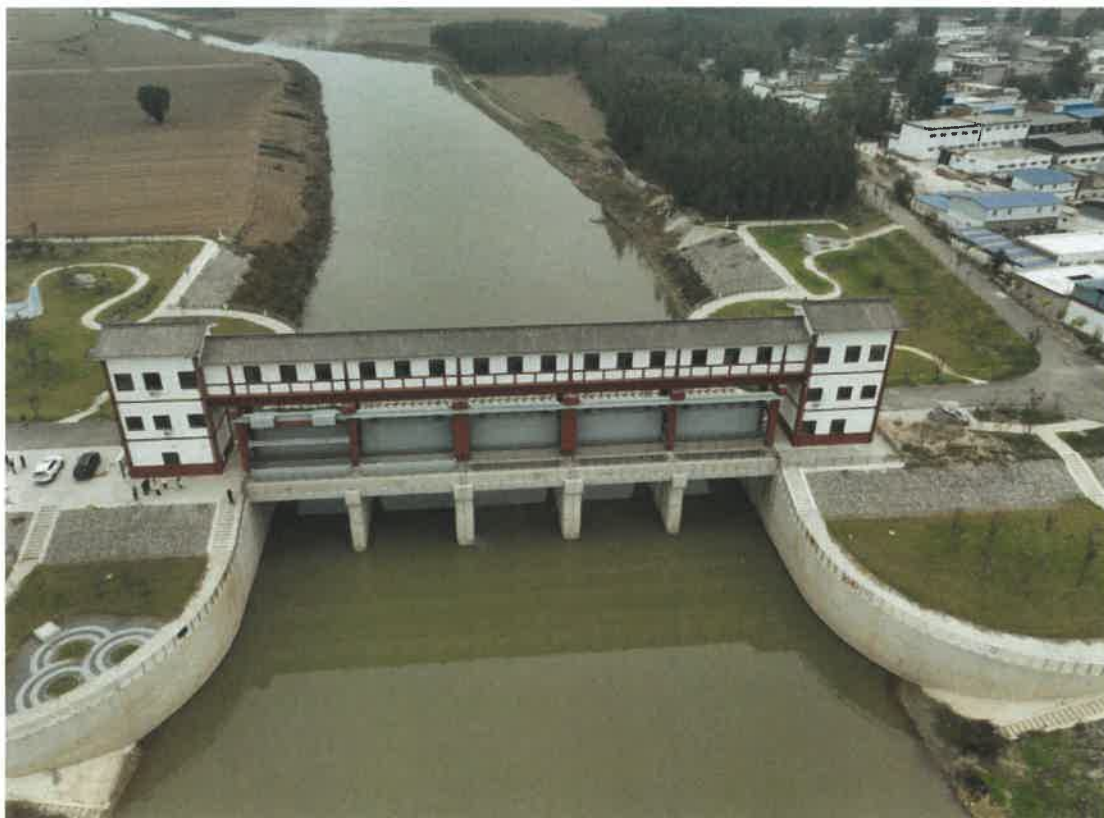
小河口节制闸主体现状（2024.9）
