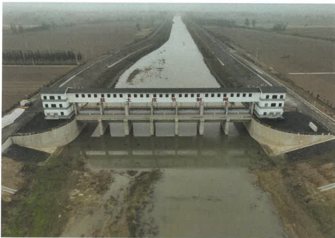
盐土庄节制闸主体现状，空地硬化，上下游河岸防护（2024.9）
