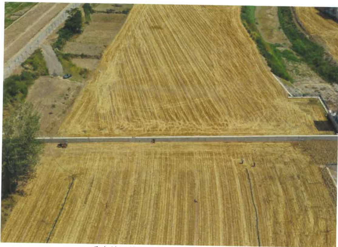
码头村围埝施工道路恢复 (2024. 8)
