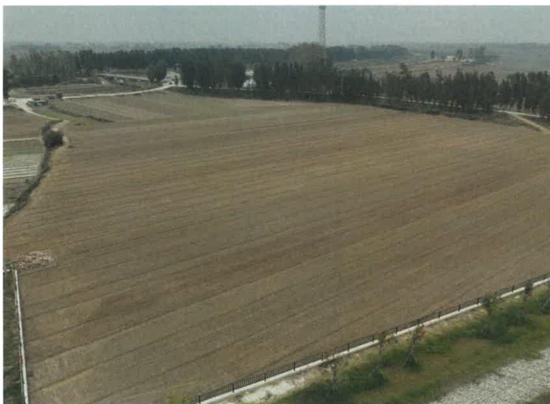
小河口节制闸施工场地恢复（2024.9）
