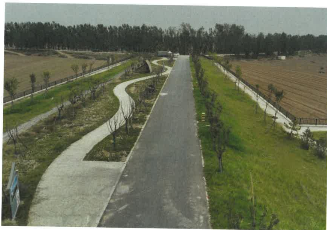
小河口节制闸施工道路恢复 (2024. 9)
