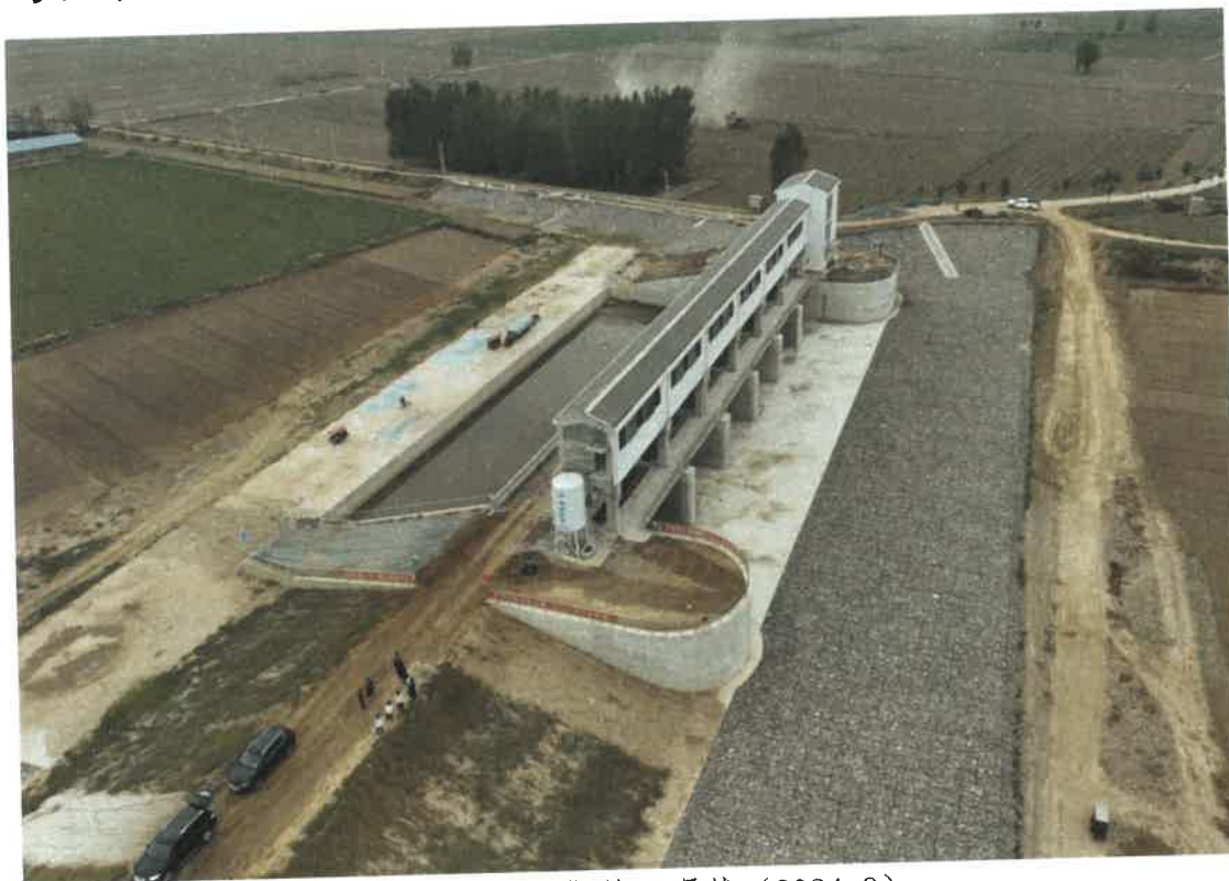
长虹渠分洪闸堰施工现状（2024.9）
