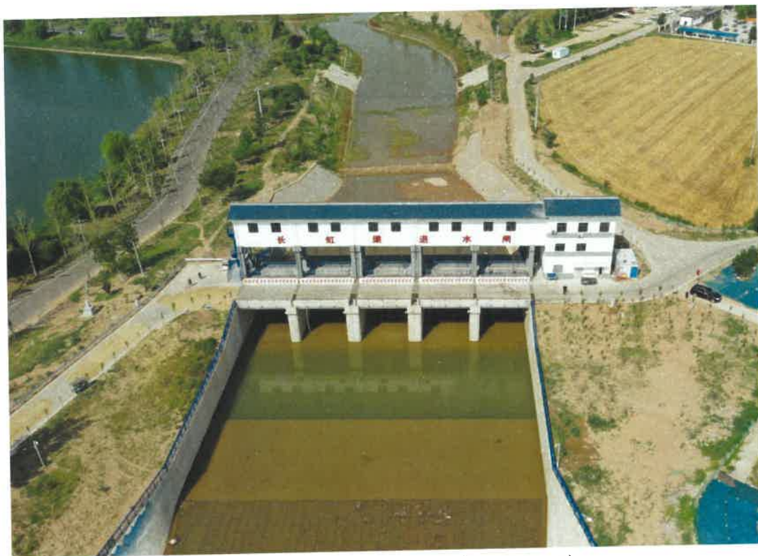
长虹渠退水闸现状，空地绿化 (2024. 7)
