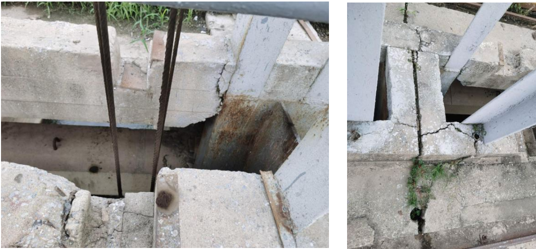
图 3.2.1-7 吴村节制闸门槽
