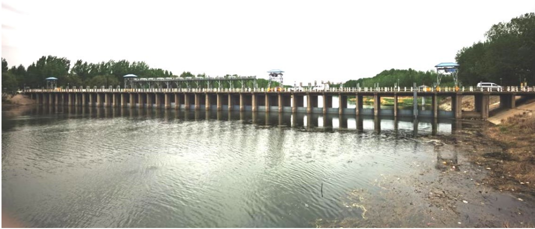
图 3.2.1-1 吴村节制闸上游全景
