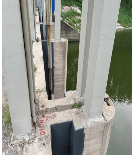
图 3.2.1-11 牛牧屯防洪引水闸启闭机室及门槽现状
