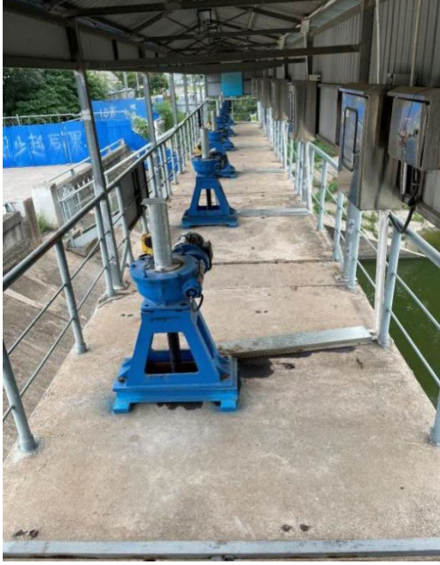
图 3.2.1-11 牛牧屯防洪引水闸启闭机室及门槽现状
