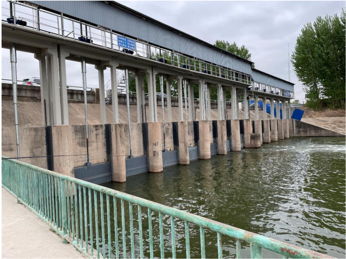
图 3.2.1-9 牛牧屯防洪引水闸上游全景
