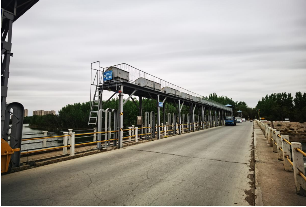
图 3.2.1-6 吴村节制闸生产桥及启闭机排架
