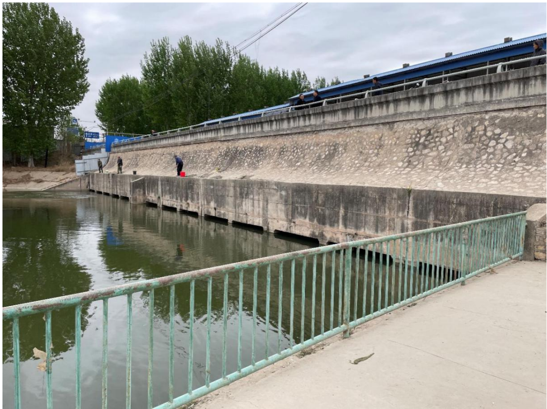
图 3.2.1-10 牛牧屯防洪引水闸下游全景
