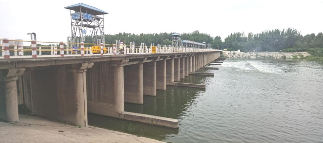
图 3.2.1-2 吴村节制闸下游全景
