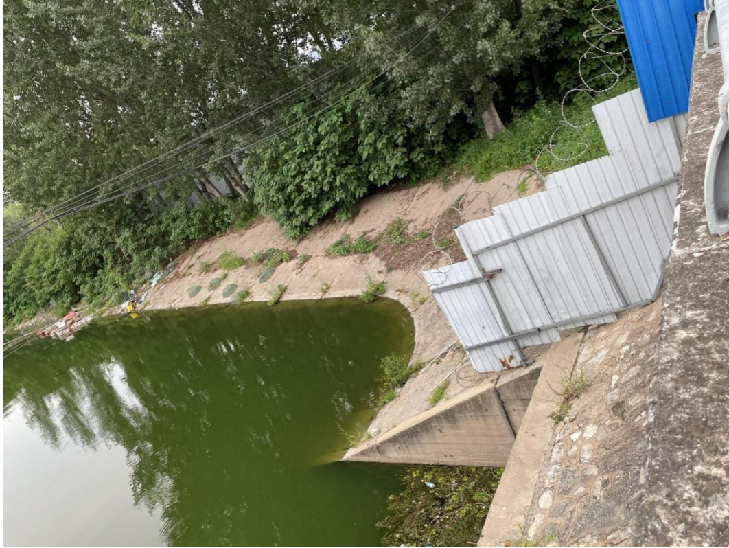
图 3.2.1-15 牛牧屯防洪引水闸下游右岸现状
