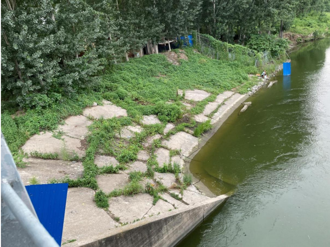
图 3.2.1-13 牛牧屯防洪引水闸上游右岸现状
